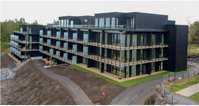
Prosjektet består av to bygningskropper som henger sammen.
